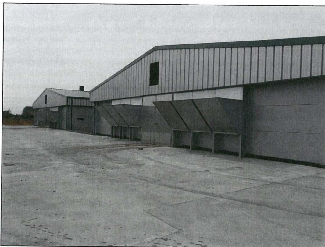
Rysunek 19. Przykład wykonania obudowy wentylatorów szczytowych, jakie proponuje się w wariantcie II (źródło: Big Dutchman).
