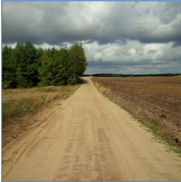
Fot. 1. Droga dojazdowa do miejsca inwestycji.
